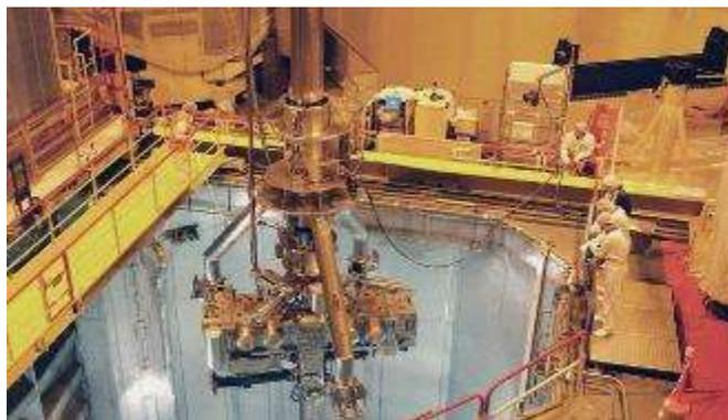
**Робот MIS осматривает внутреннюю часть корпуса реактора в ходе планового ремонта АЭС «Бюже», Франция**
