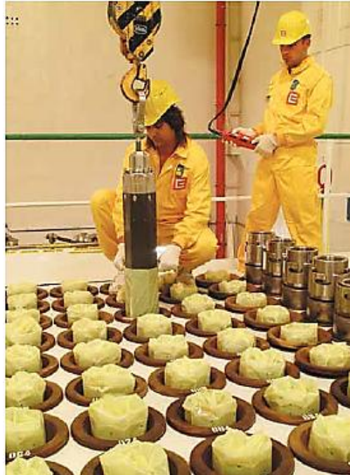
Загрузка топлива на АЭС
